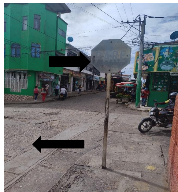
IMAGEN 32. En este sector se observa el mal estado de las señales de tránsito tipo vertical y horizontal SR-01, se sugiere la instalación de 03 reductores de velocidad con su señalización vial
