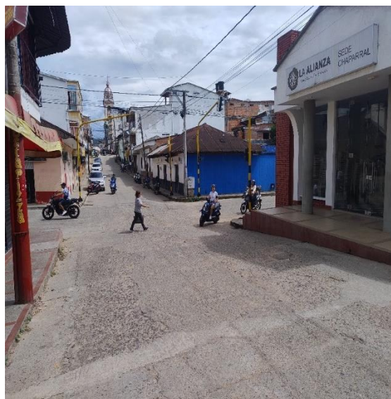
IMAGEN 36. Se observa sobre la Calle 9 con cra 6 la falta de señalización vial tipo horizontal P-06 zona peatonal
