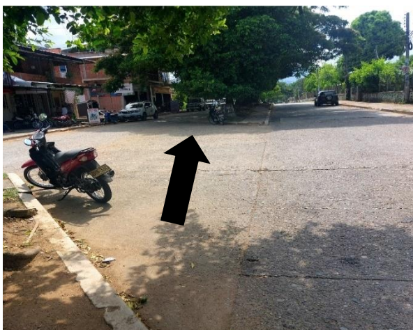
IMAGEN 65. Sobre el sector de la cra 10 avenida los colegios donde se observa sitio donde no se respeta el sentido vial por lo cual se deberá instalar bolardos plasticos en el sector con su respectiva señalizacion SR-06
