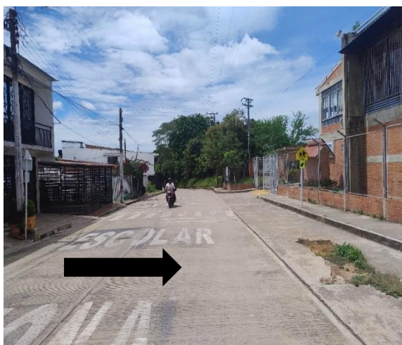
IMAGEN 51. Se observa el deterioro de las señalización vial tipo horizontal de SP -47 zona escolar.
