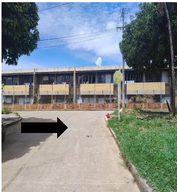
IMAGEN 49. Se evidencia sobre el barrio villa café sector de los colegios se observa la falta de señalización vial tipo horizontal y vertical de zona escolar SP-47
