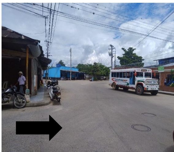
IMAGEN 47. Cra 10 con calle 2 se puede evidenciar falta de señalización vial sobre el sector la cual el sitio es un punto de alta peligrosidad por la estructura de la vía, se requiere instalación de señales de tránsito verticales y horizontales P -06 zona peatonal
