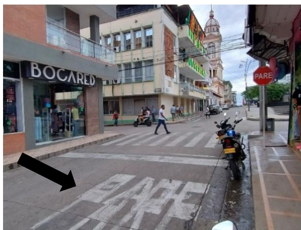
IMAGEN 3. Calle 9 con cra 10 y 9 se evidencia la falta de señalización horizontal SR-01 y P-06 cebra o zona peatonal
